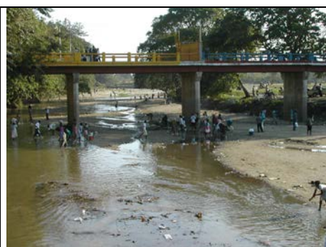
Foto 67 - El río Masacre en la ciudad de Dajabón erosionando su llanura de inundación hacia el sur y con depósitos transicionales de arenas medias a gruesas (Lat.: 19.54849 Long: -71.71177)
