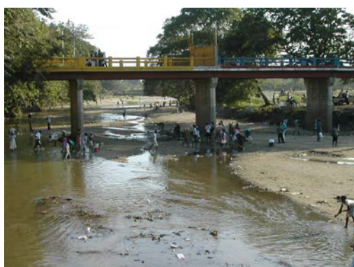
Foto 82 - (DAJ_MAS21) - El puente del río Masacre en la ciudad de Dajabón erosionando su llanura de inundación
