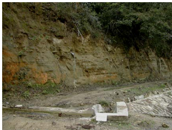
Foto 42 - Presa de Chacuey: capas horizontales de areniscas gris marrón naranja, de grano fino a medio, con niveles más carbonatados, decimétricos, lenticulares (//S0). Se notan los drenajes preventivo de la presa (03PU9960: Lat.: 19.62225; Long.: -71.54579)
