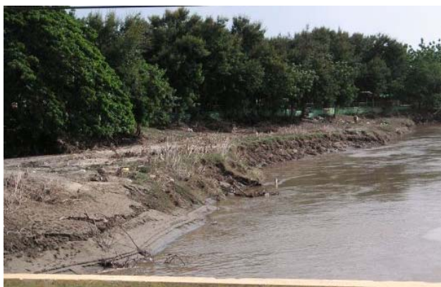
Fig. 135: Aspecto de los aluviones del Río Yaque del Norte en el Puente de Castañuelas.
