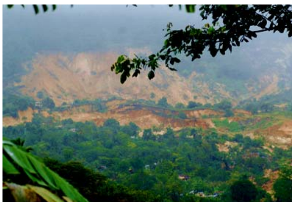
Fig. 180: Deslizamiento de laderas - Vista del deslizamiento en masa ocurrido el 12 de Febrero 2009 en Carlos Díaz
