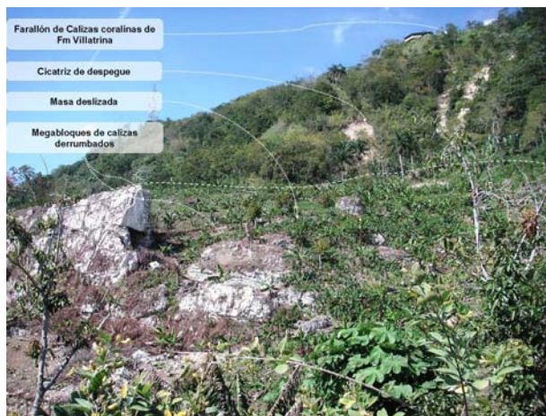
Fig. 175: Deslizamiento de laderas Vista de los mega bloques de calizas derrumbados en la cabecera del deslizamiento de La Cumbre las Cabirmas en Alto de los Pozos
