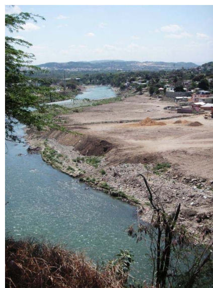
Fig. 145: Terrazas bajas -Vista hacia el Sur de las terrazas bajas arrasadas durante la Tormenta Olga el 12 de diciembre 2007
