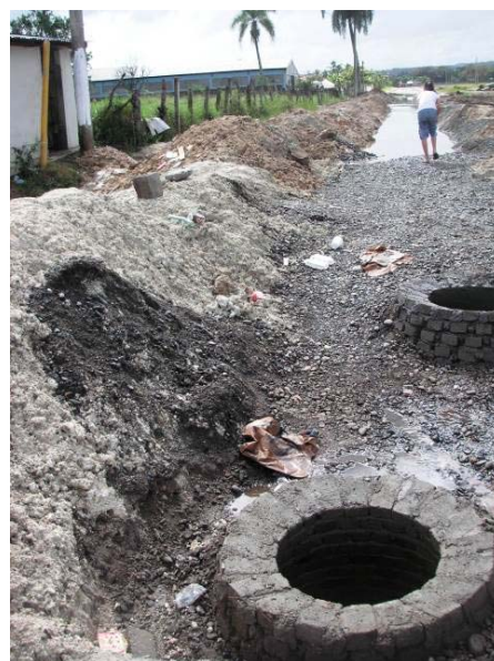
Fig. 131: Unidad de Licey al Medio - Calicatas de drenaje en suelos arcillosos impermeables de arcillas calcáreas blancas amarillentas caliche infrayaciendo el glacis de suelos negros
