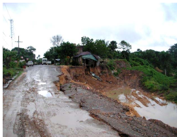
Fig. 129: Unidad de Lacey al Medio - Vista de un deslizamiento de la carretera de Moca La Vega en Llenas
