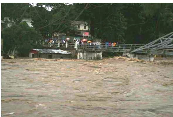
Fig. 186: Riesgos de inundación Vista de la crecida del Río Yaque en el estrechamiento del valle en Bella Vista
