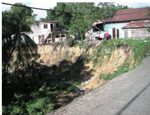
Fig. 182: Deslizamiento de laderas - Vista de un deslizamiento en las arcillas de la Unidad Licey al Medio
