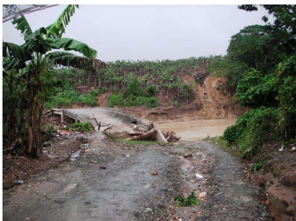
Fig. 198: Riesgos de deslizamientos Puente Bonagua derrumbado con deslizamiento en la ribera opuesta
