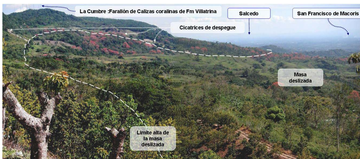
Fig. 188: Riesgos de deslizamientos vista panorámica desde alto de los Pozos hacia el SE del deslizamiento de la Cumbre las Cabirmas
