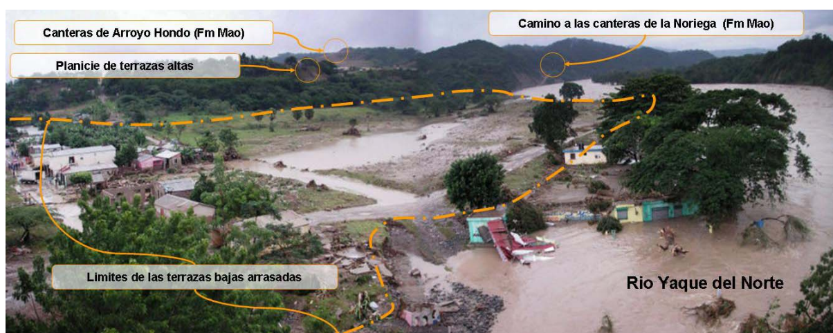
Fig. 143: Terrazas bajas -Vista de las terrazas bajas arrasadas por el río Yaque en el Puente de la Avenida Olímpica durante la Tormenta Olga el 12 de diciembre 2007.
