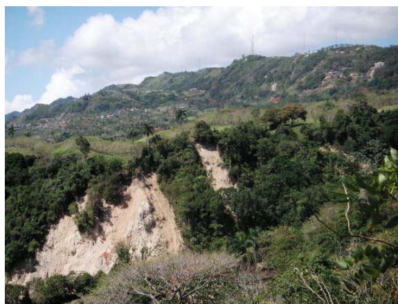
Fig. 190: Deslizamiento de laderas Vista hacia el Noroeste de la parte oriental del deslizamiento de la Cumbre las Cabirimas con deslizamientos secundarios actuales. 25PU9825 Lat.: 19.47909/Long.: -70°50103
