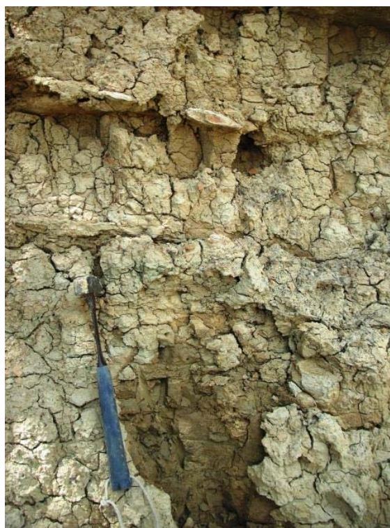
Fig. 94: Formación Mao - lutitas y siltitas: Arcillas con grietas de desecación importantes laminadas calcáreas con 10% de niveles siltsos poco calcáreos.
