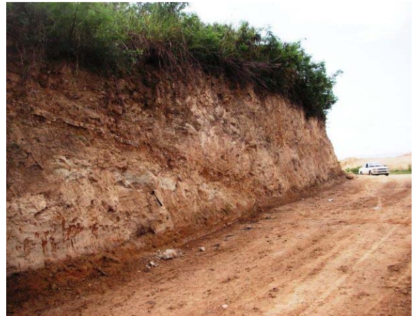
Fig. 100: Calizas de Palo Amarillo - Vista de los niveles de Calizas coralinas tableadas.
