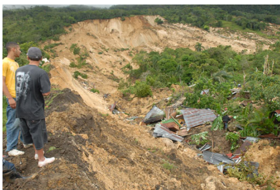
Fig. 191: Riesgos de deslizamientos Vista del deslizamiento en masa ocurrido el 11 de Febrero 2009 en Carlos Díaz (foto de prensa Cosas del cibao.com)
