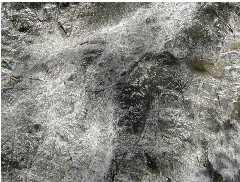
Foto 6: Afl. 04JM9254. Gabro de grano grueso, fuertemente fracturado.
