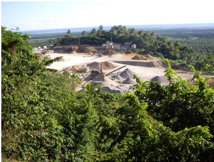
Foto 12. Vista de las instalaciones de Agregados Santa Bárbara
